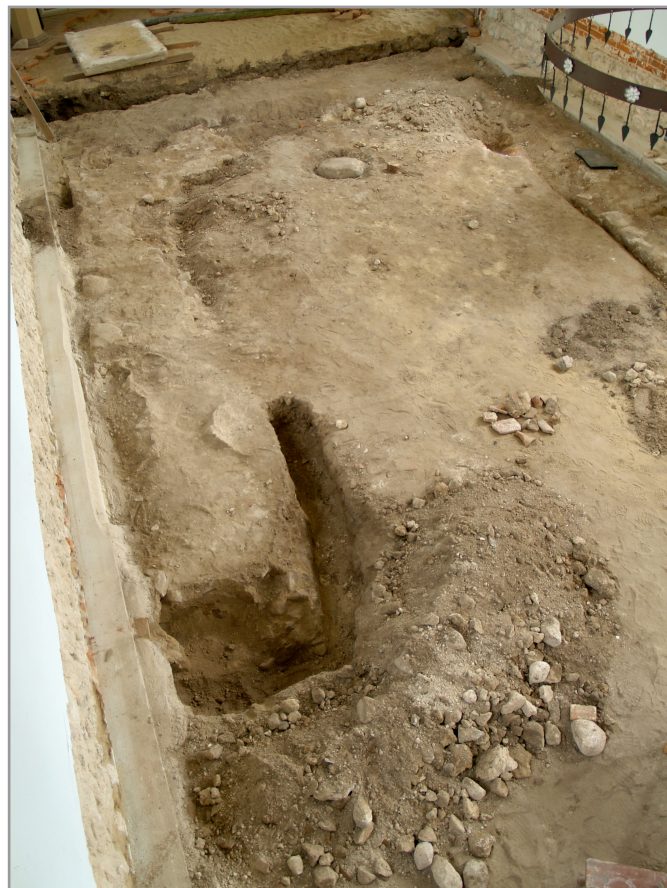
Abb. 3: Erdreich unter dem aufgenommenen Saalfußboden.
