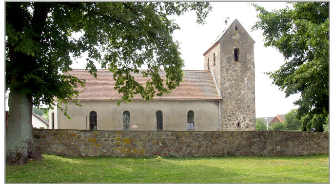
Abb. 1: Pfarrkirche Vienau. Nordansicht. Turm spätromanisch. Saal von 1868 mit eingezogener polygonaler Apsis.
