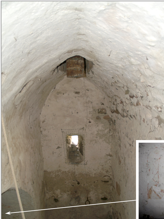
Abb. 4: Südseite im Turmerdgeschosses.
