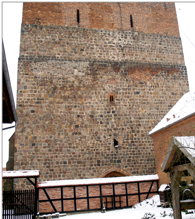
Abb. 1: Westseite des Westturms der Osterburger St. Nicolaikirche. Feldsteinmauerwerk romanisch. (Foto: Verfasser, 2013)
