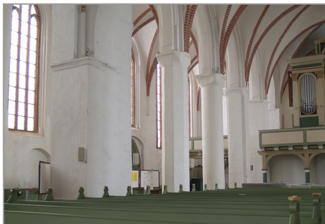
Abb. 2: Südliche Stützenreihe. Querschnitt der westlichsten Stütze quadratisch, nach Osten hin folgen kreuzförmiger, kreisförmiger und achteckiger Querschnitt. Links im Vordergrund ein Vierungspfeiler. (Foto: Verfasser, 2013)
