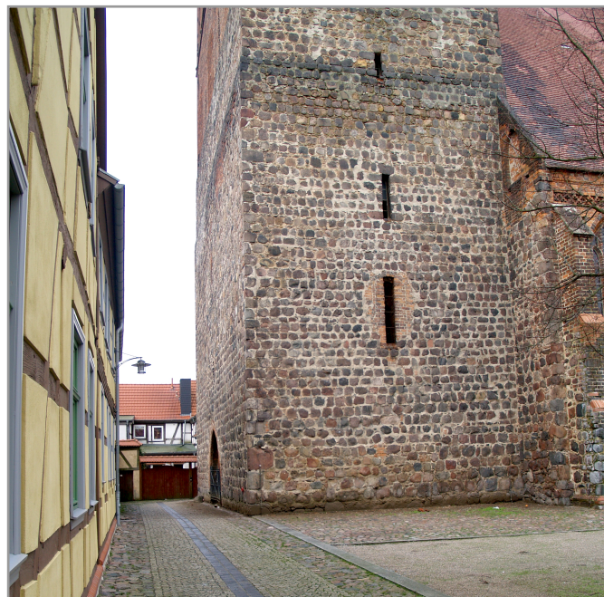
Abb. 1: St. Nicolai Osterburg, Westturm, Ansicht aus SSW. (Foto: Verfasser, 2013)
