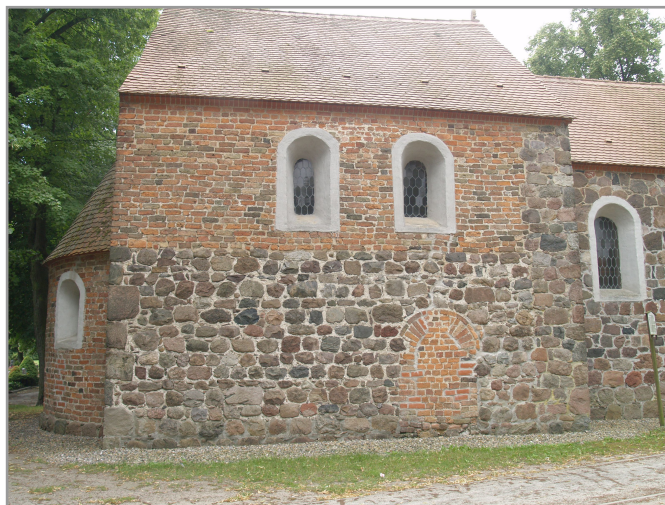
Abb. 1: Nordseite der Martinskapelle auf dem Osterburger Friedhof. Von der ursprünglichen Kirche an diesem Platz zeugen die Feldsteinmauern des Chores und der Sockel der Apsis. Anstelle des Saales ist 1866 ein kurzer Anbau, schmaler als der Chor, errichtet worden.
