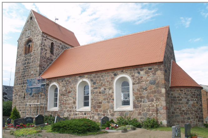
Abb. 2: Südostansicht der Kirche in Düsedau. Von der ursprünglich dreiteiligen Kirche mit Chor, Saal und Turm stehen noch der Turm und die Westhälfte des Saales. Der Chor wurde 1869 auf Saalbreite vergrößert und die Kirche mit einer Apsis versehen.
