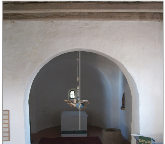
Abb. 5: Blick von der Orgelempore durch den Triumphbogen in den Chor. Aus dem Scheitelpunkt des Triumphbogens fällt das Lot (weiße Strecke). Achse des Objektivs, Saalachse und Triumphbogenlot liegen in einer Ebene. Die Lage des Osterfensters zum Lot zeigt den Linksknick in der Gebäudeachse an.
