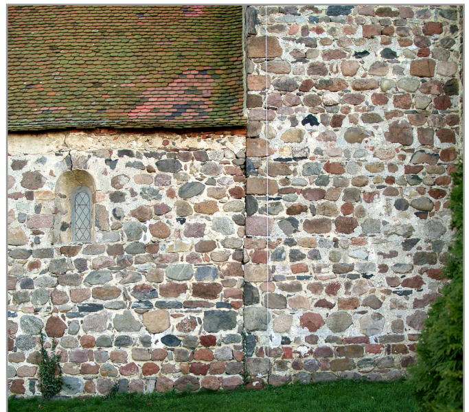
Abb. 2: Baunaht zwischen Turm und Saal auf der Nordseite der Kirche in Buchholz.
