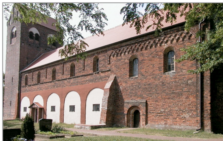
Abb. 1: Langhausbasilika in Königsmark. SO-Ansicht. (Foto: Verfasser, 2003)
