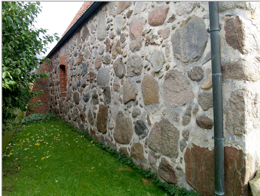
Abb. 4: Mauerwerk der Kapellennordwand. (Alle Fotos von H.-P. Bodenstern, 2012.)
