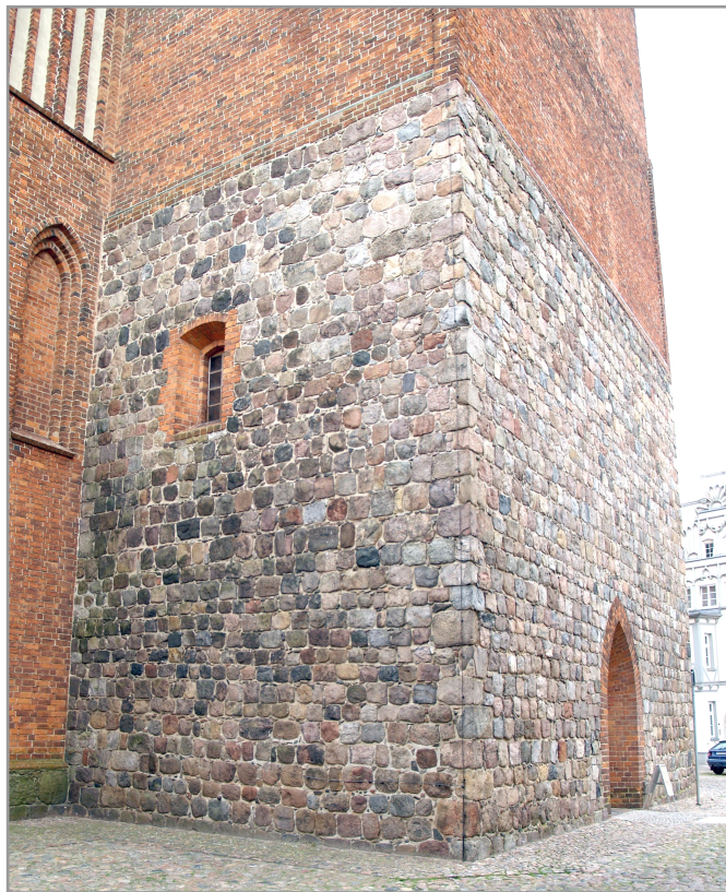
Abb. 1: Nordwestliche Ansicht des romanischen Feldsteinturms der Perleberger St. Jakobi Kirche. (Fotos vom Verfasser)
