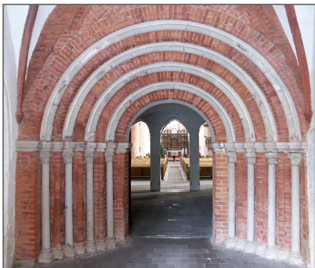
Abb. 1: Westportal der St. Petri Kirche in Seehausen (Altmark), Westansicht. Fotos: H.-P. Bodenstern (2004, 2007)
