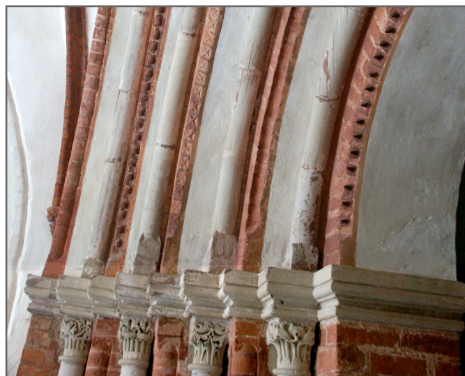
Abb. 2: Portalbogen mit Sandsteinarchivolten und verzierten Bogenkanten. Nordwestansicht.
