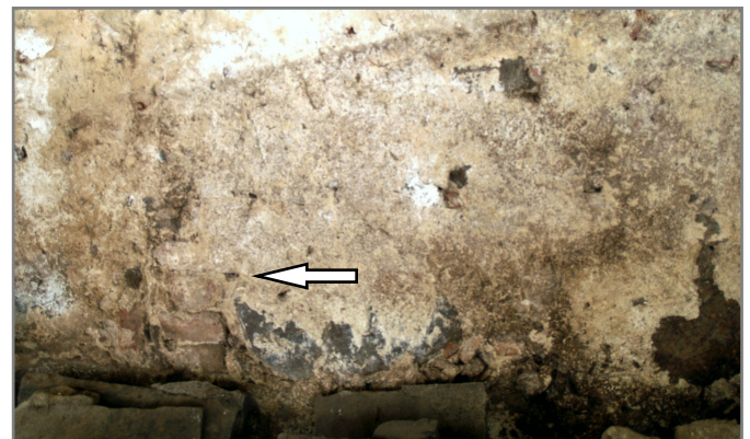
Abb. 4: Westwand des K-Hauses, Innenseite. Andeutung (südliche Laibung mit Kämpfer) einer rundbogigen Öffnung. (Fotos 3 u. 4: Verfasser, 2011)
