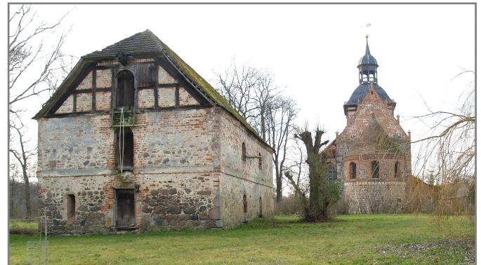
Abb. 3: Blick von Osten auf die Kreveser Basilika und das K-Haus. Der Gebäudeabstand beträgt 12 Elten-Klafter. Die Achse der Basilika liegt 7 Elten-Klafter nördlicher als die des K-Hauses.
