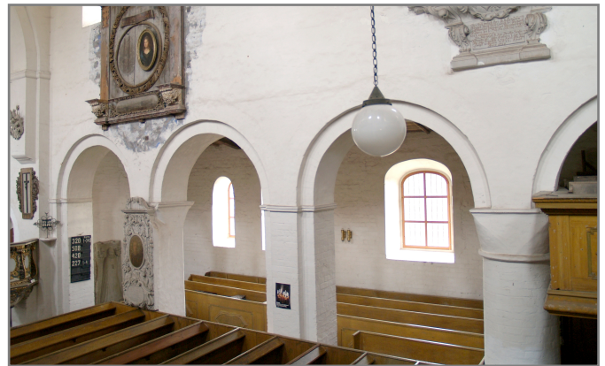
Abb 6: Basilika Schönhausen. Die östlichen Bögen der Südarkade. (Foto: Verfasser, 2009)
