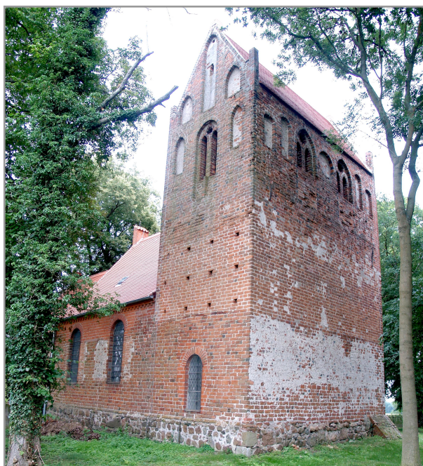
Abb. 2: Calberwischer Westturm. NW-Ansicht. Bauabschnitte erkennbar. (Fotos: Verfasser)
