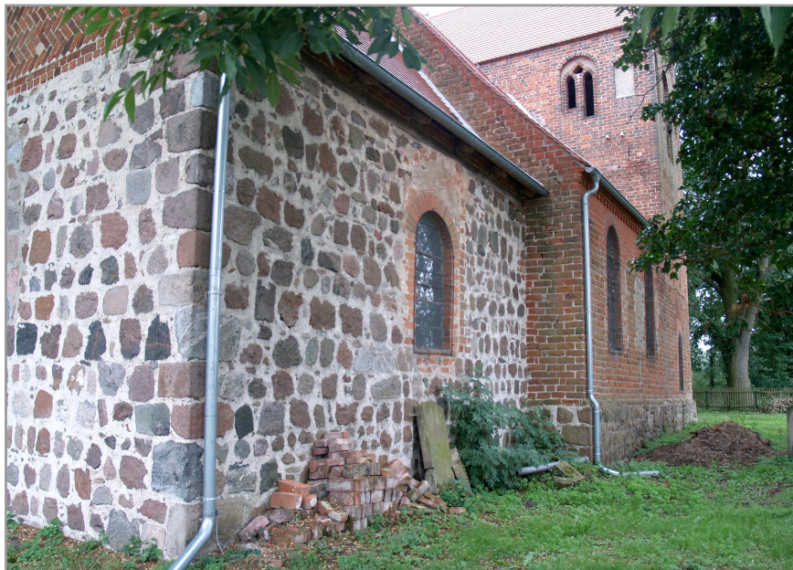
Abb.1: Dreiteilige Kirche in Calberwisch. NO-Ansicht. Chor in Feldstein-, Saal und Turm in Backsteinbauweise.
