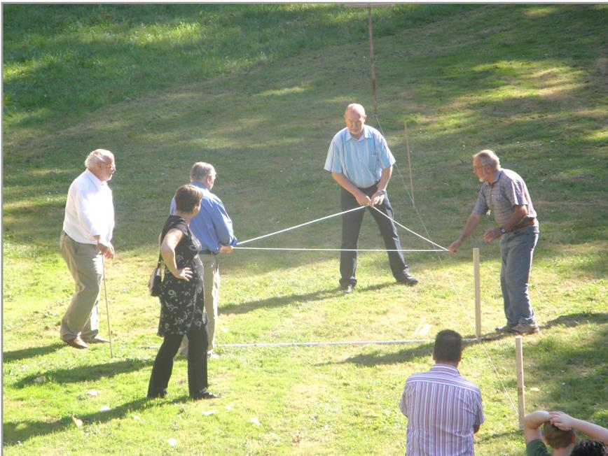
Abb. 2: Mit der Knotenschnur wird ein rechter Winkel angelegt. (Foto: Dietlinde Boden-stein, 2012)
