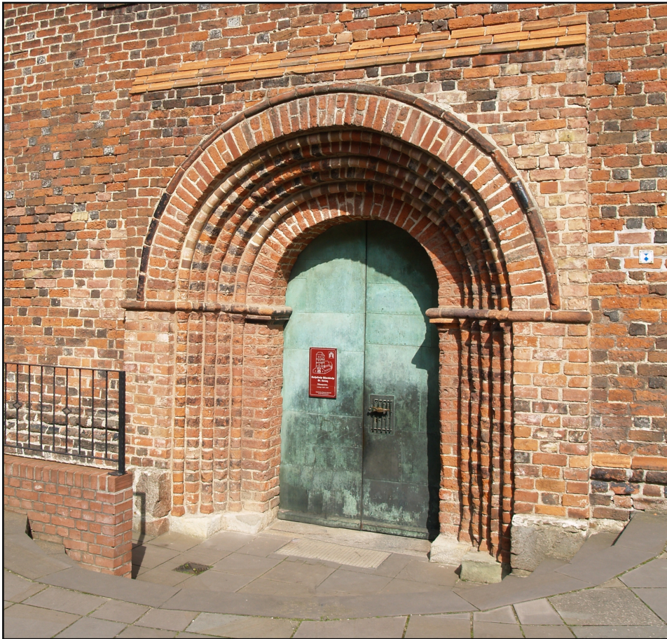
Romanisches Westportal der St. Lorenz Kirche zu Salzwedel. (Foto: Verfasser, 2012)
