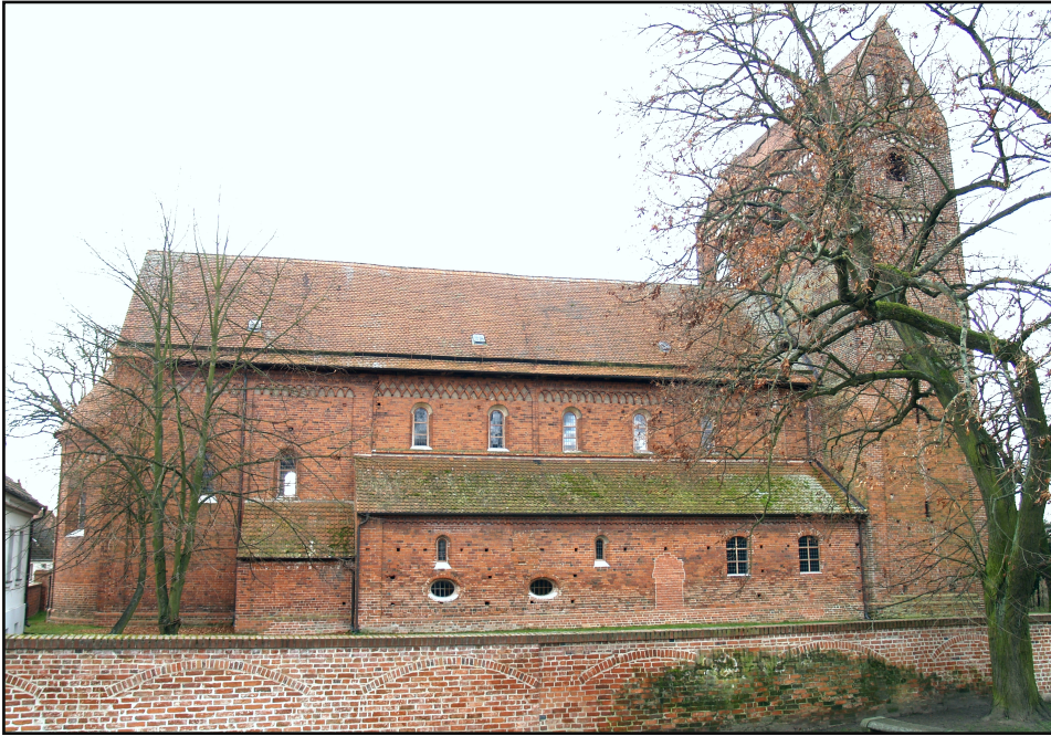
Nordansicht der Langhausbasilika in Schönhausen an der Elbe. (Foto: Verfasser, 2010)
