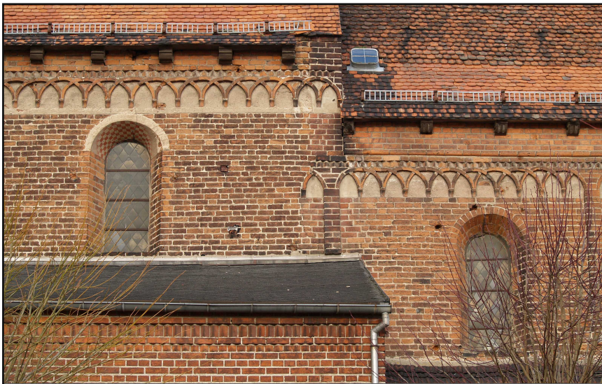
Basilika in Sandau. Das von Westen (von links) herangeführte Mittelschiff ist gegenüber dem schon stehenden Chor (rechts) etwas zu hoch geraten.
